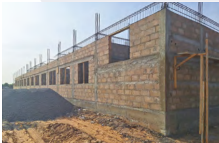
Bâtiment en construction
